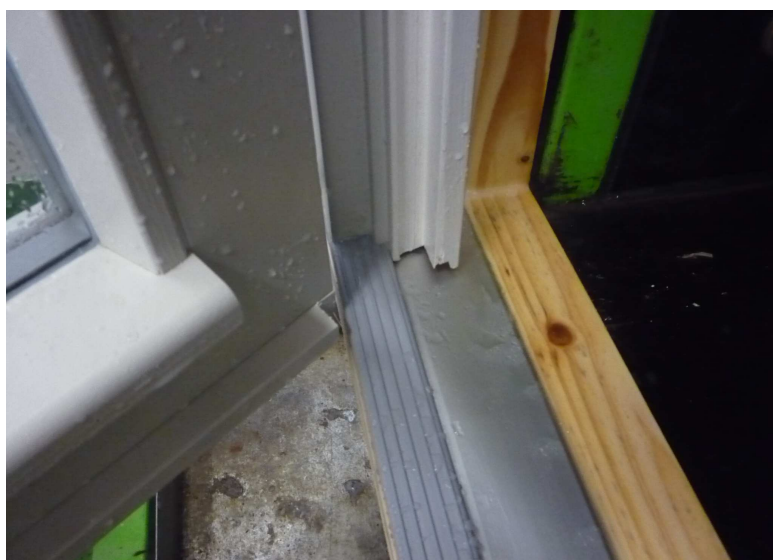
Détail liaison ouvrant / dormant
